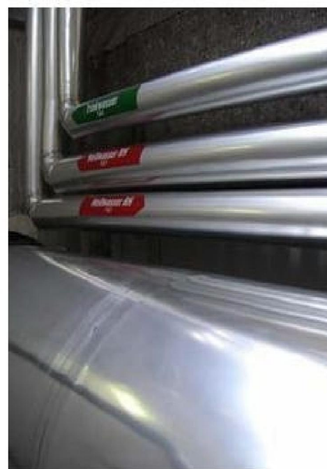
LI Laminat 573 może być instalowany na rurach, zbiornikach, kanałach itd.
