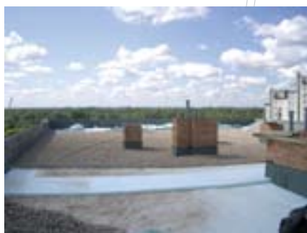
Izolacja dachu płaskiego
