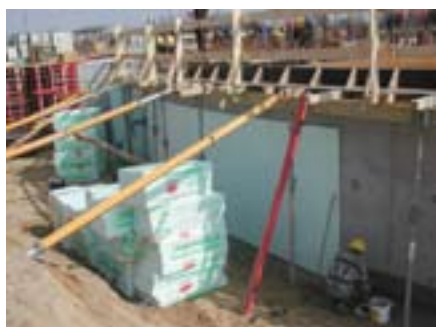
Izolacja ściany fundamentowej
